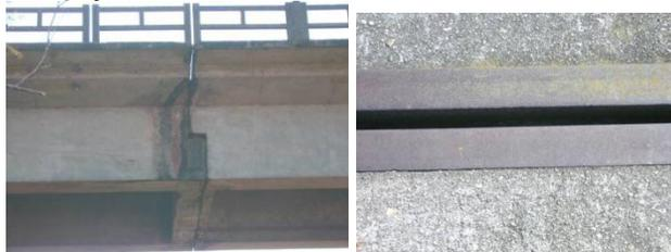
Figura 2 – Pequeno espaço deixado entre os blocos de concreto de uma ponte, devido à dilatação térmica.
